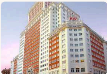
Edificio Plaza España Madrid - Gran vía, Plaza España
